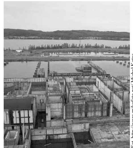
Niedokończona budowa głównego budynku Elektrowni Jądrowej Żarnowiec.
